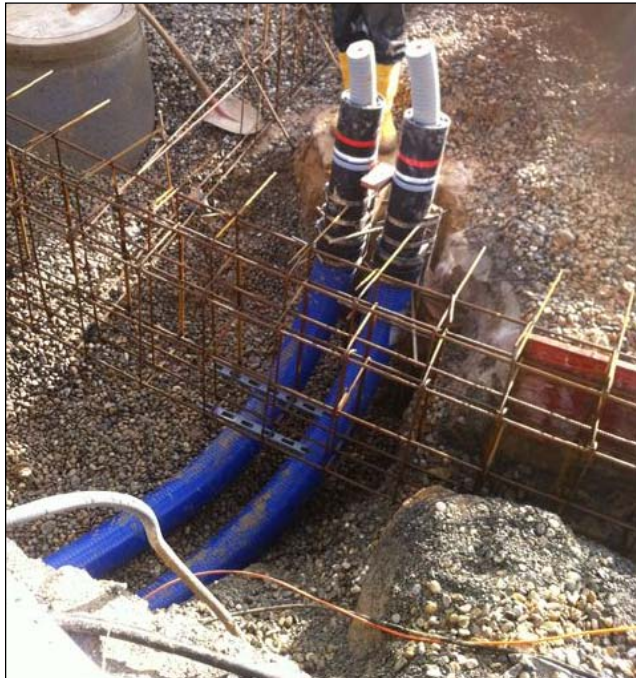
Abbildung: Vormontierte Leerrohre vor der Ausführung der Bodenplatte
