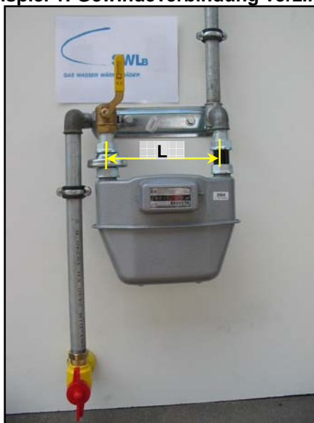
Beispiel 1: Gewindeverbindung verzinkt
