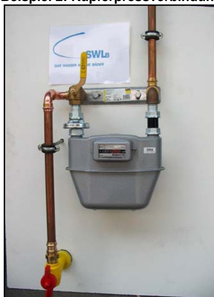
Beispiel 2: Kupferpressverbindung
